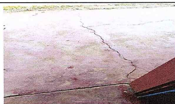
Foto 6: se observa daños en el piso del edificio
