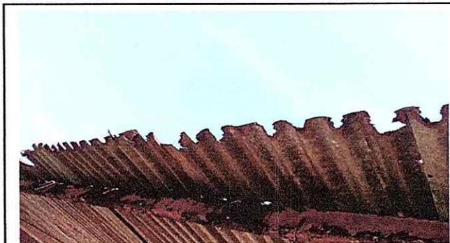
Foto1: Sustitucion de Techo
